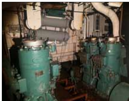
Maskinrummet på Fladen
