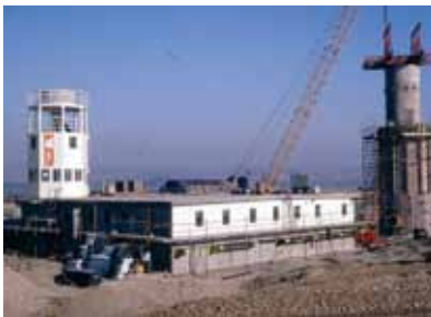
Bostadssektionen och fyrtornet under uppbyggnaden
