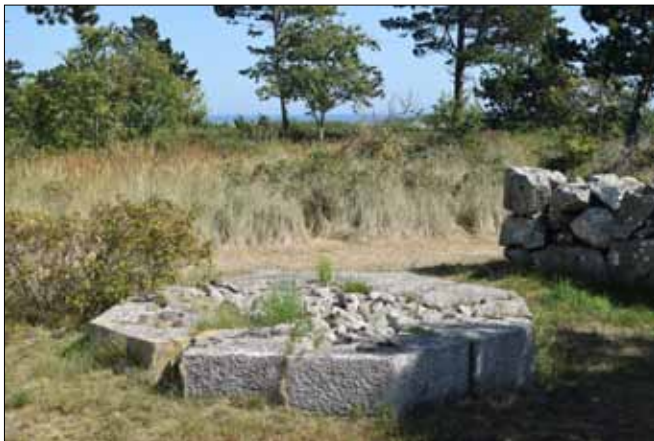
Fundamentet till den första fyren, blott 8 meter hög, finns kvar bredvid den nya fyren.
