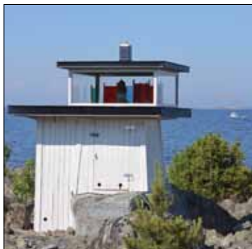
Bergöns fyr. Det gamla fyrlyuset är fortfarande fullt funktionsdugligt men har ersatts av ett modernt LED-ljus ovanpå den gamla.
